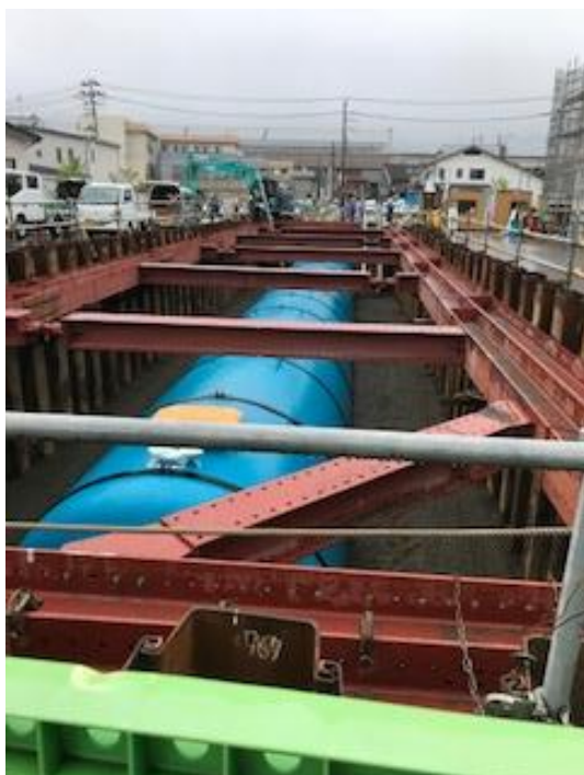
大容量の防火水槽を建設中
