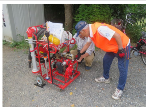
D級ポンプ点検の様子
