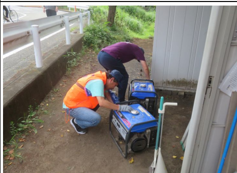
発電機点検の様子
