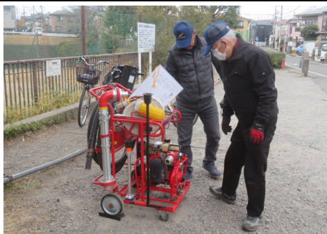
D級ポンプ点検の様子
